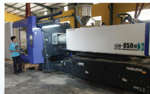
Bộ phận ép phụ tùng ống Fitting making department
